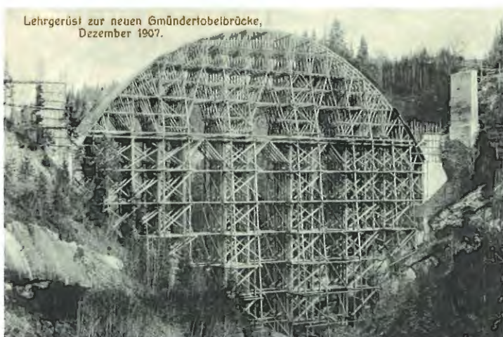
Das Lehrgerüst der Gmündertobelbrücke.
