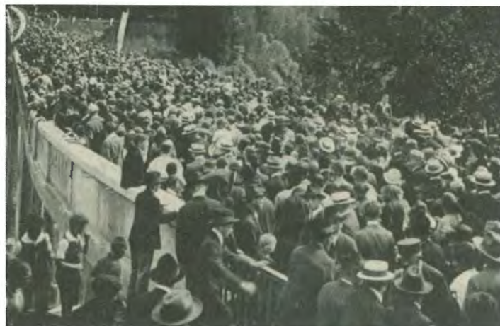
«Freude herrscht» – Einweihung der neuen Hundwilertobelbrücke am 23. August 1925.
