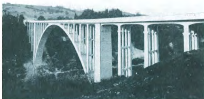
Die fertige Hundwilertobelbrücke im Jahre 1925.
