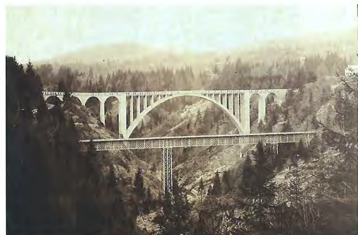
Die vollendete Eisenbetonbrücke über das Gmündertobel (Sitter) mit der vorherigen Eisengitterbrücke.
