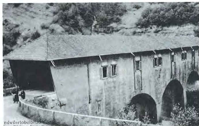
Die alte gedeckte Hundwilertobelbrücke .
