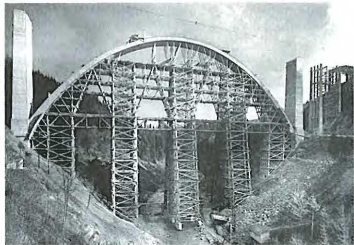
Das Lehrgerüst der Hundwilertobelbrücke, vollendet am 7. Juli 1924.
